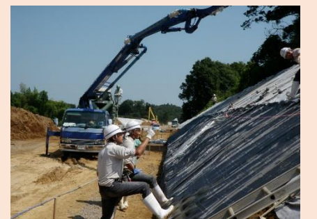
布製型枠作業
