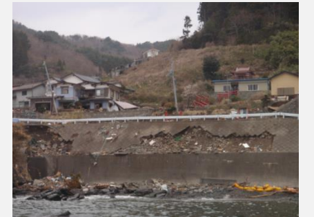
津波被害状況調査(東京大学)
