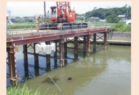
ブロック据付
